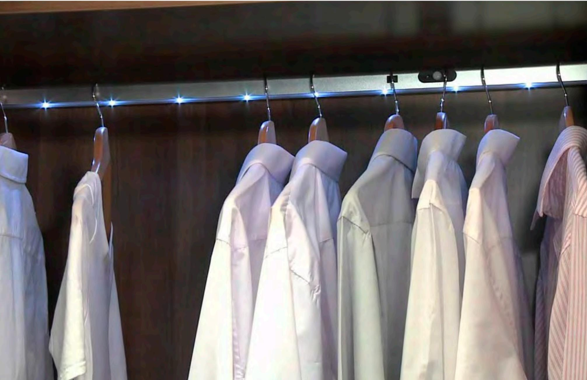
Iluminación interior de todos los armarios de la vivienda mediante tiras LED incorporadas a la barra de colgar y dirigidas a la parte superior del armario.
