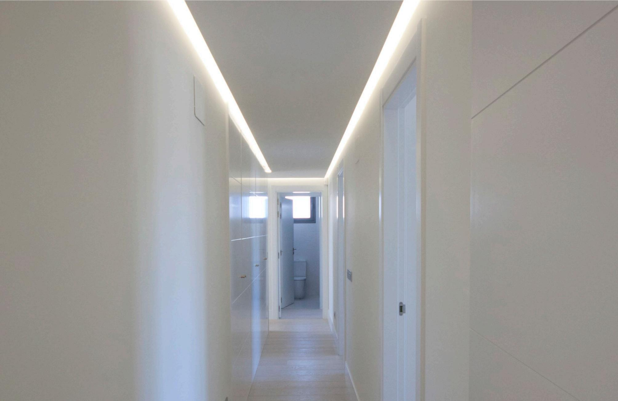
Foseado en falso techo para iluminación indirecta de tira de LED. Irá ubicado de forma perimetral en recibidor y distribuidor como se señala en el esquema.
